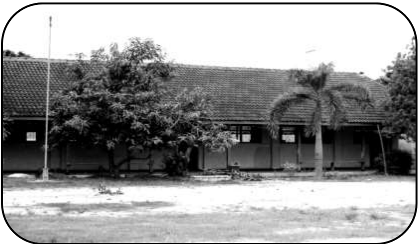
Gedung SMP “Yos Sudarso” – Bandar Jaya, Lampung
